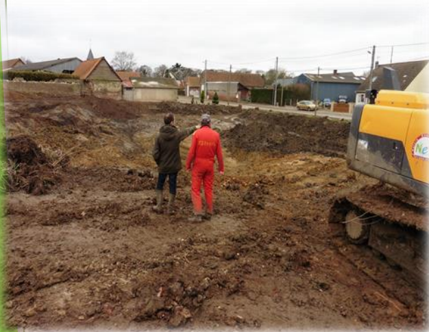
9 - Suivi et réunion de chantier
