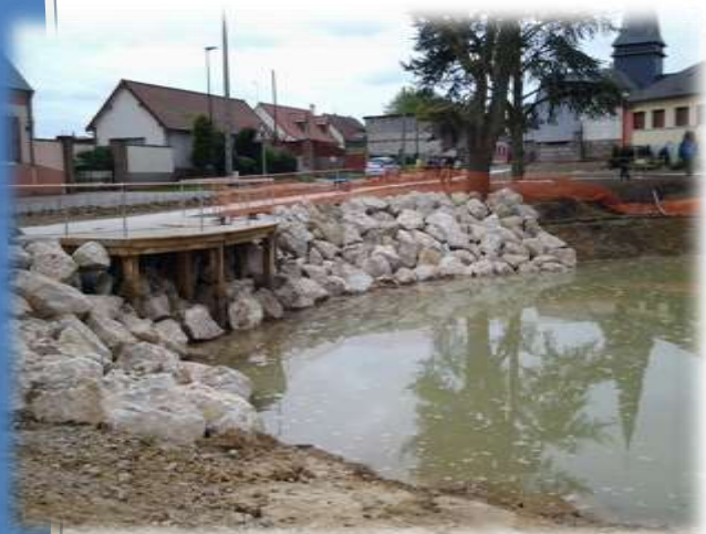
11 - Création de la sente piétonnière, mise en place du ponton, réfection de voirie et mis en défens
