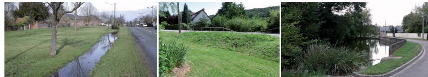
Noues d'infiltration, espaces verts inondables et mares communales : des techniques alternatives au « tout réseau » mises en œuvre dans nos communes (ici par exemple à Blargies, Incheville et Lamaronde)
