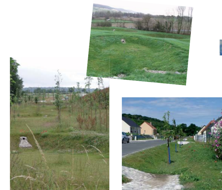
La gestion des eaux pluviales à la source est exigée dans les nouveaux lotissements (ici par exemple à Monchaux-Soreng, Blangy-sur-Bresle et Longroy)
