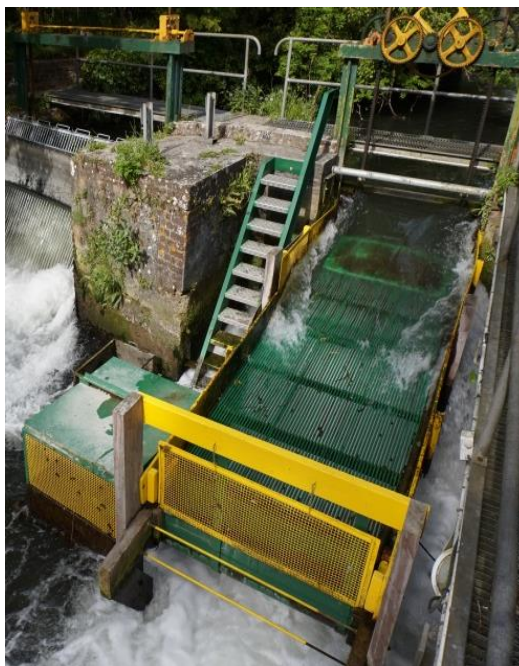
Figure 38 : Vue du dispositif de piégeage de dévalaison d'Eu
