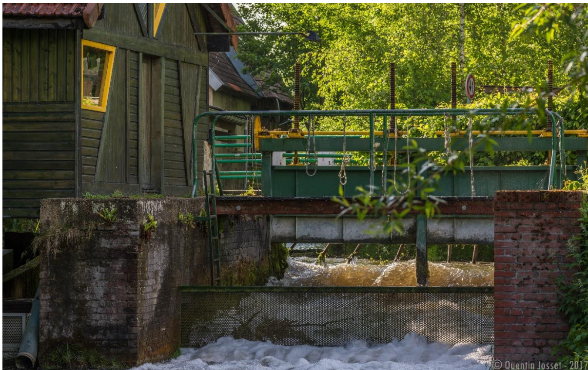
Figure 5 : Vue aval du piège du Lieu-Dieu (Beauchamps - 80) en fonctionnement
