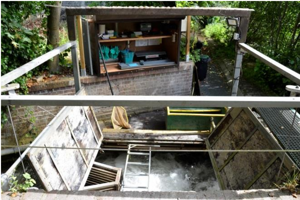
Figure 21 : Vue du piège de montée en fonctionnement
