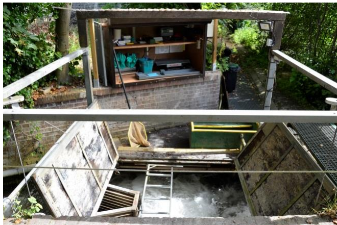
Figure 10: Vue du piège de montée en fonctionnement
