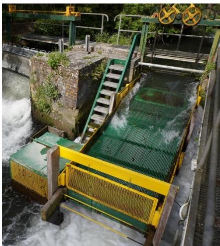
Figure 9 : Vue du dispositif de piégeage de dévalaison d’Eu
