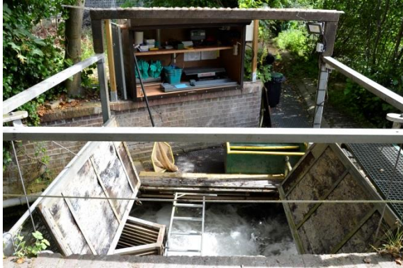
Figure 11: Vue du piège de montée en fonctionnement
