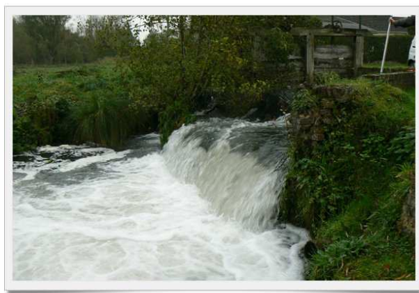
Les organes hydrauliques liés au moulin seront supprimés : bief envasé et chute difficilement franchissable pour les poissons
