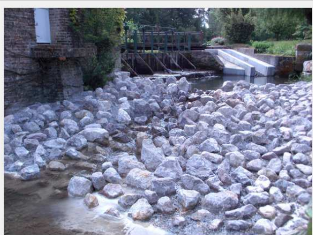
La rampe à enrochement avant sa mise en eau
