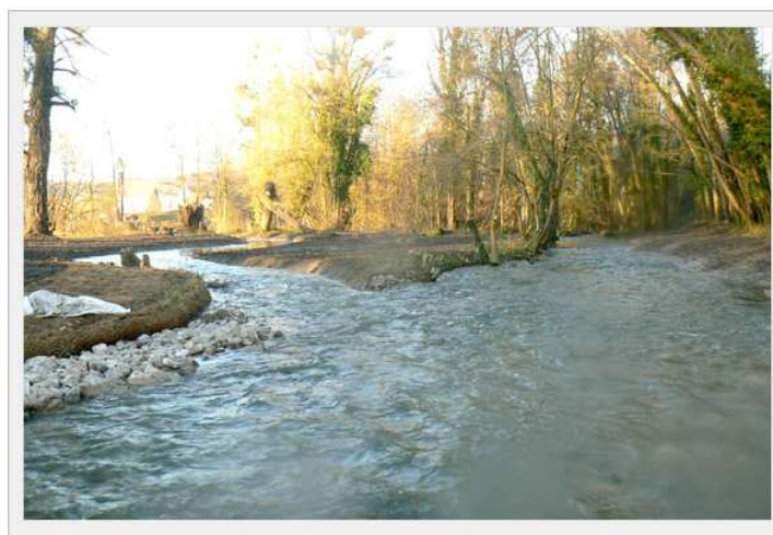
La mise en eau du tracé
