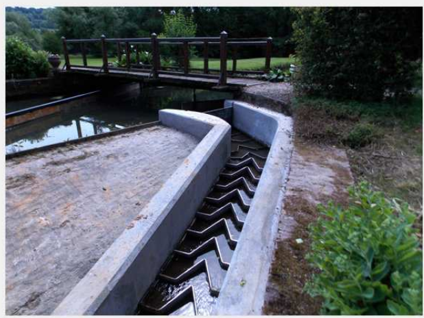
La passe à ralentisseurs avant sa mise en eau
