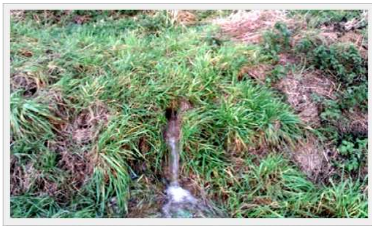
Fuite dans la berge de la Rieuse à Monchaux Soreng et inondation d'une parcelle de culture
