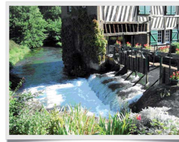
Le moulin Laroche : un magnifique ouvrage permettant d'actionner une pompe à chaleur et d'assurer le chauffage de l'habitation Crédit photo : Arnaud Richard, ONEMA
