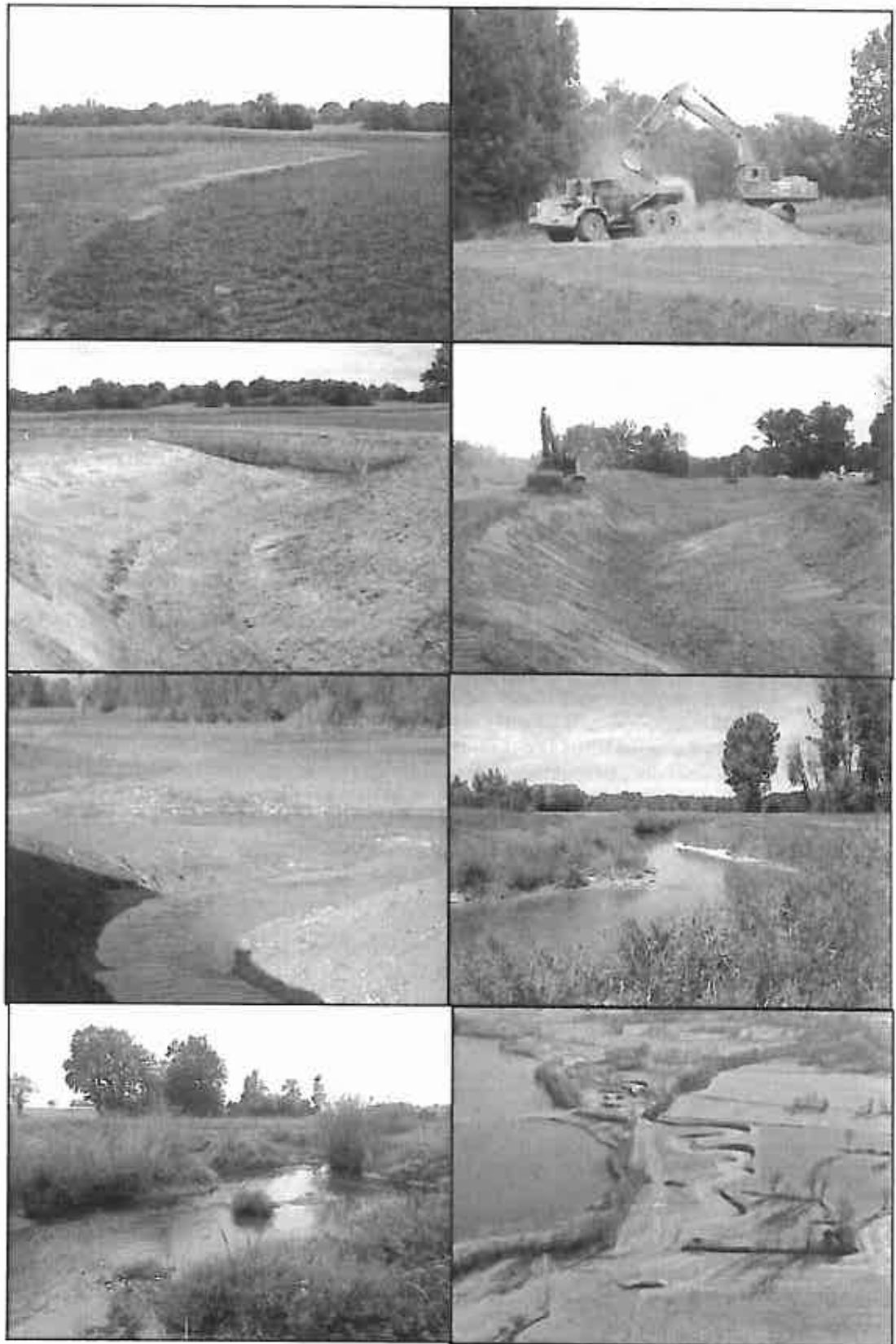
Figure 5. Illustrations successives de l'opération de création d'un nouveau lit de la Veyle au droit du plan d'eau de la gravière de St-Denis-les-Bourg (01) (conception et maîtrise d'œuvre : Biotec). Chantier de 2009.
