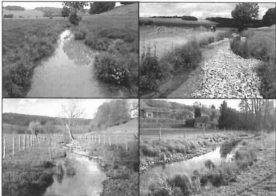
Figure 3. Illustrations successives de l'opération de restauration physique et fonctionnelle du Foullebrec sur la commune de Touffreville (dept. 76) via, notamment, la mise en œuvre de bancs graveleux à des fins de rétrécissement de la section hydraulique (vues « avant » (image haute et gauche) et « en cours » de chantier) - Conception et maîtrise d'œuvre : équipe d'ingénieurs d'étude du bureau Biotec.
