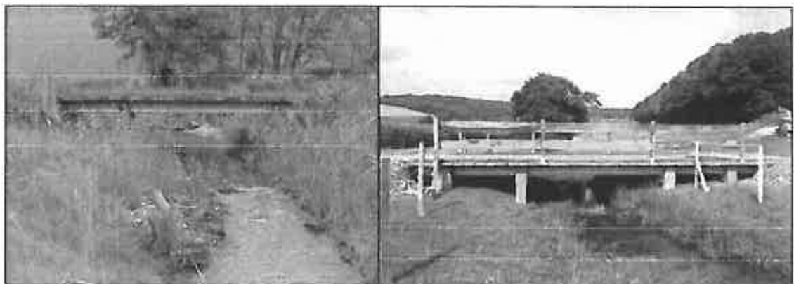
Figure 4. Illustrations de « passerelles bois sur poutrelles métalliques » mise en œuvre dans le cadre de différents chantiers de restauration physique de cours d'eau (clichés Biotec).
